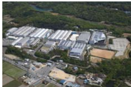
川崎重工西神戸工場 Nishi-kobe Works
